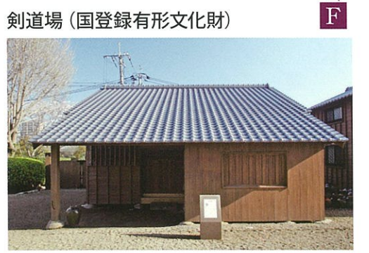
剣道場 (国登録有形文化財) 慶応3年築と伝えられ、明治12年に邸内に移築されたといわれています。 床が低く、釘が上から打たれていないのが特徴で、後には炭などが保管されていました。
